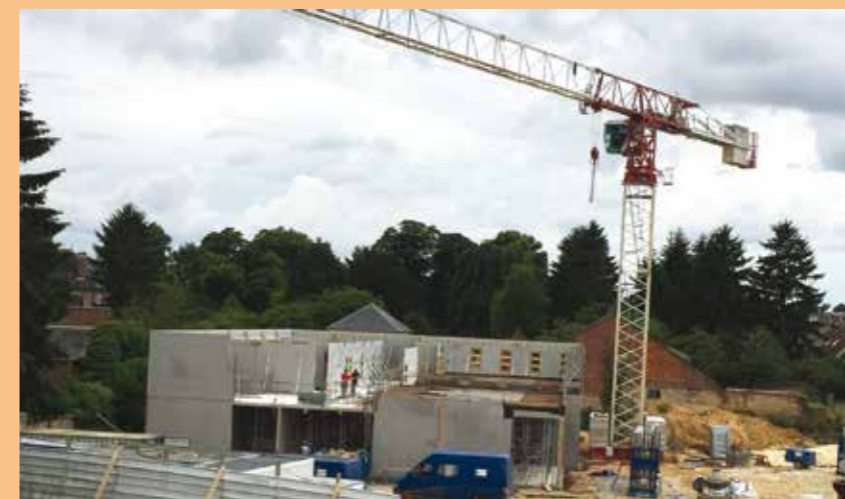
Les travaux de l'école de musique avancent. Le plancher du 1 er étage a déjà vu le jour.
