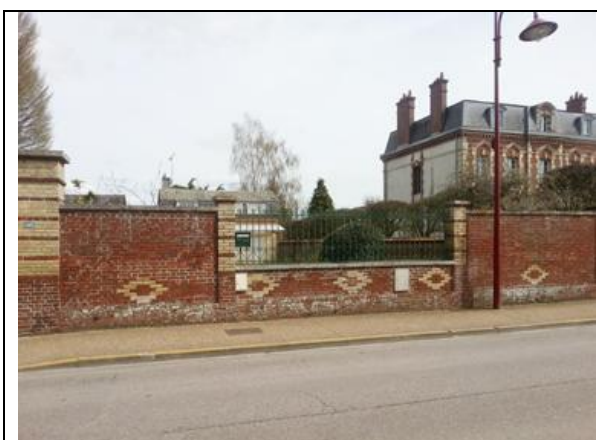
Clôture en brique surmontée d'une grille en fer forgée
